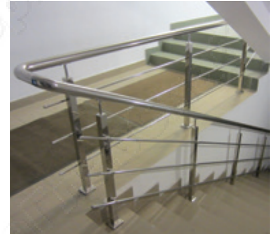
Ограждение лестницы и площадки со стойками k743, тремя ригелями и поручнем Ø50,8мм из нержавеющей стали.
