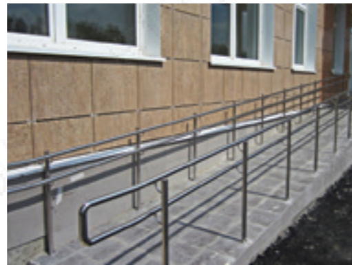
Ограждение пандуса поликлиники со стойками к750 и двойным поручнем Ø38мм из нержавеющей стали.
