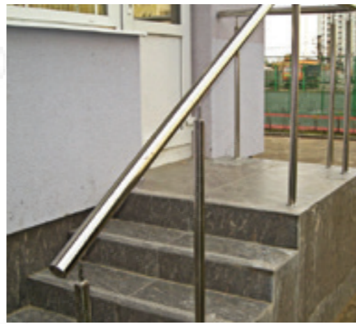
Ограждение крыльца эконом-вариант со стойками к702 и поручнем из нержавеющей стали Ø50,8мм.
