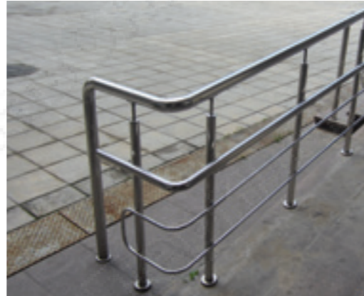
Ограждение входной группы бизнес-центра со стойками к751 и двойным поручнем из нержавеющей стали.
